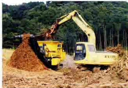
土地造成(伐採材破碎)
